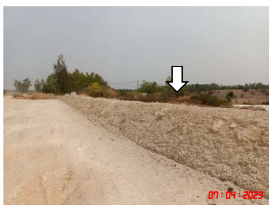
รูปที่ 13 คั่นทำนบดินรอบพื้นที่ลานกองแร่
