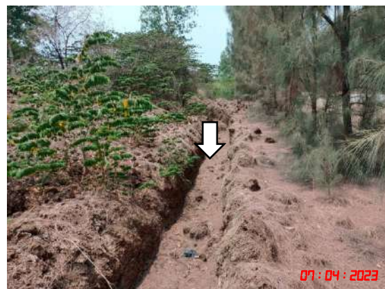
รูปที่ 14 ระบายน้ำรอบพื้นที่การทำเหมืองและพื้นที่ลานกองแร่
